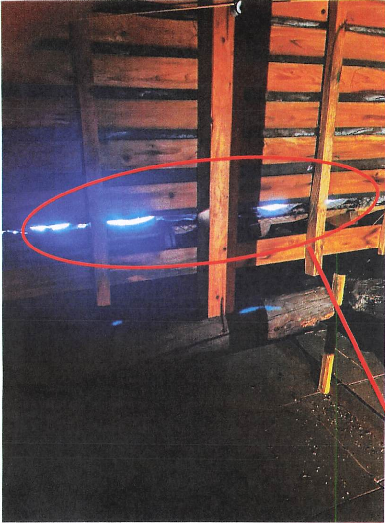
小屋裏 矢切の壁と瓦の隙間 雨風を防げる工事が必要
