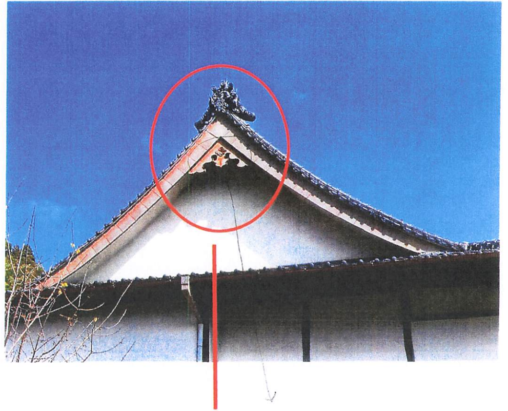
矢切壁と破風板と懸魚の新規取付
